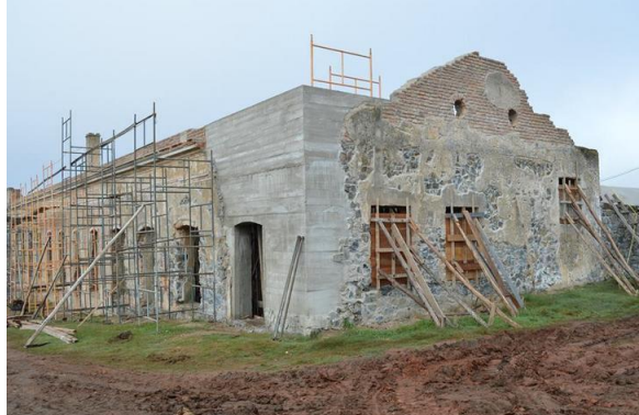
Figura 7 – Etapa de consolidação da ruína
